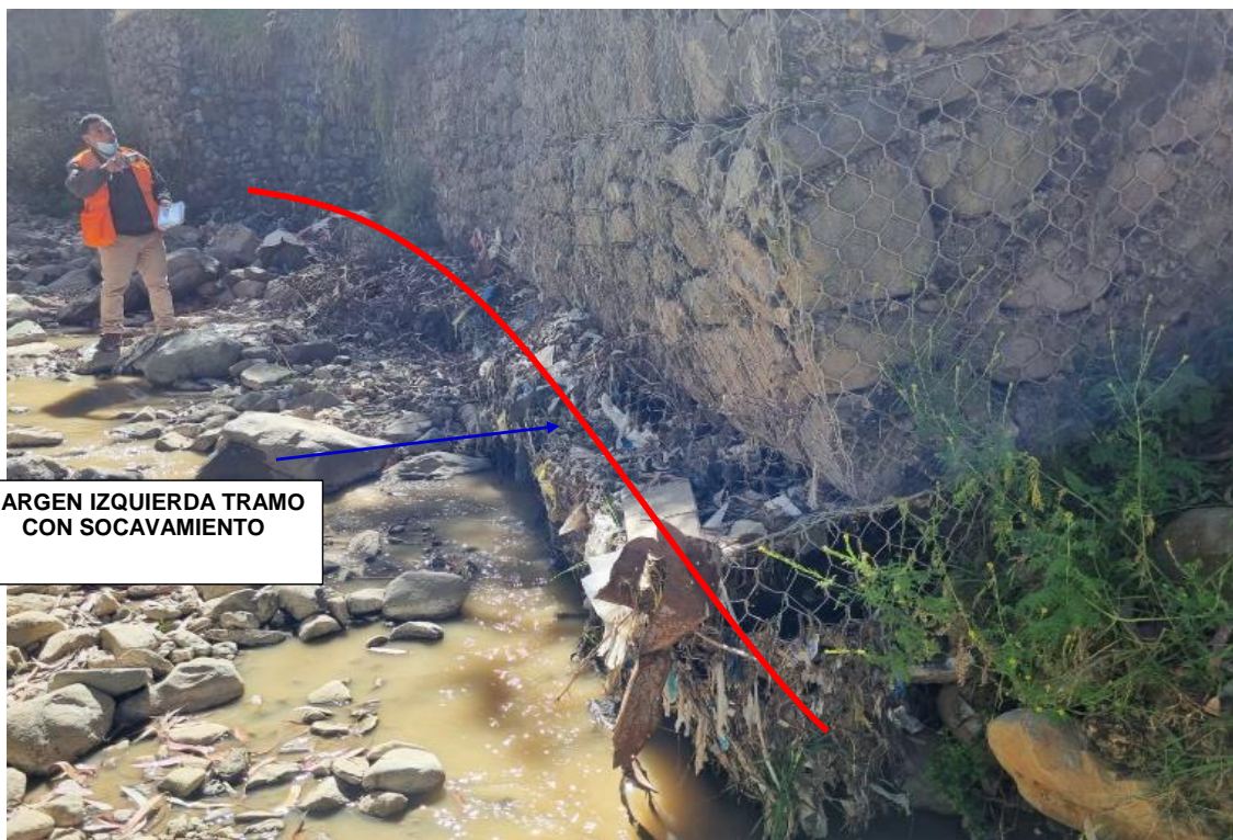
FIGURA N°03: EN LA TEMPORADA DE MAXIMAS AVENIDAS, LA QUEBRADA FLORIDO EROSIONA EN AMBAS MARGENES DEL CERCADO A LA POBLACION DE CASTROVIRREYNA.
