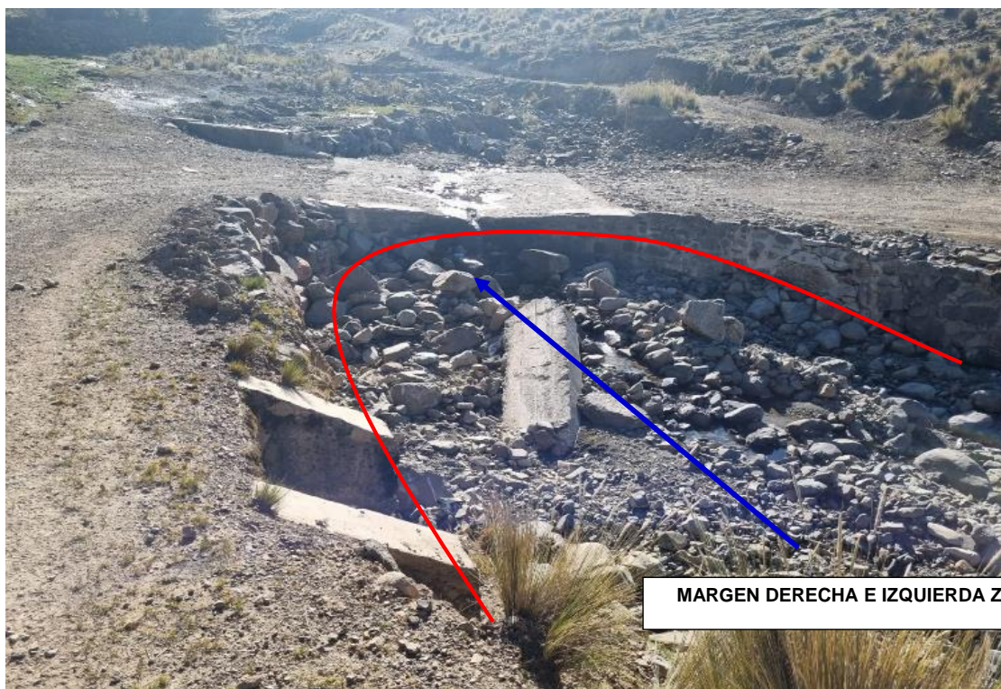
FIGURA N° 02: QUEBRADA FLORIDO SOCAVADO AFECTANDO LA CARRETERA COCAS-CASTROVIRREYNA.
